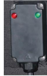
固定温度的机械式的室内温控器安装在连接盒的盖子里。当温度降至 5°C 以下时，自动启动加热，指示灯指示电源开启和加热开启。
